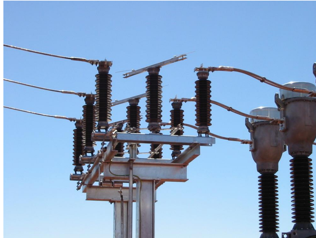
Seccionador de Potencia
